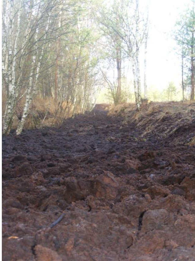
Czarne Bagno. Zasypany rów odwadniający. Listopad 2011.
